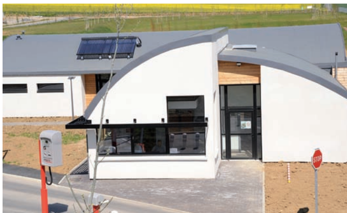
Local pont bascule de l'EcoCentre La Tuilerie
