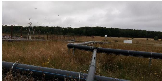
Réseau de captage de biogaz
