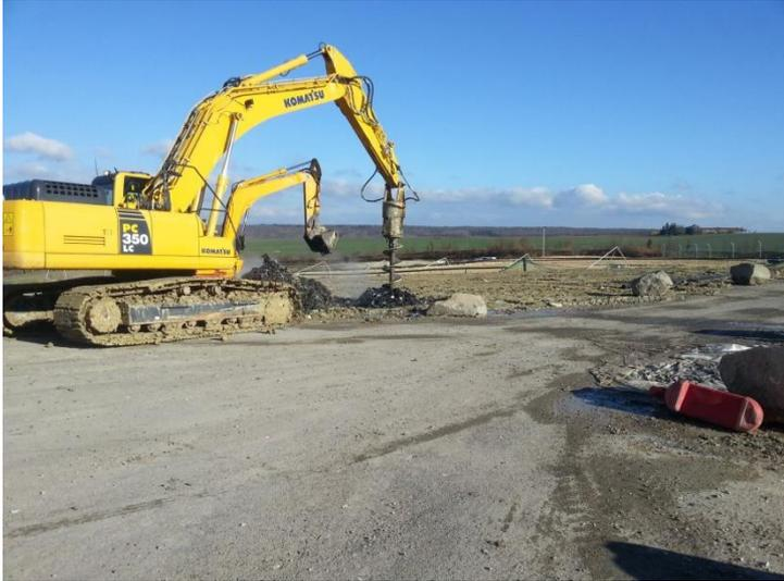
Forages de 6 puits biogaz verticaux sur les alvéoles 7 et 8 et raccordement provisoire au réseau - Semaine 20
