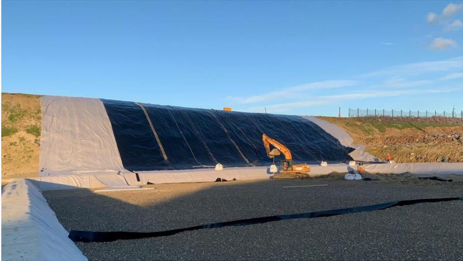
Couverture du flanc de l'alvéole 5 dans le cadre de la construction du casier 3 (alvéole 10)
