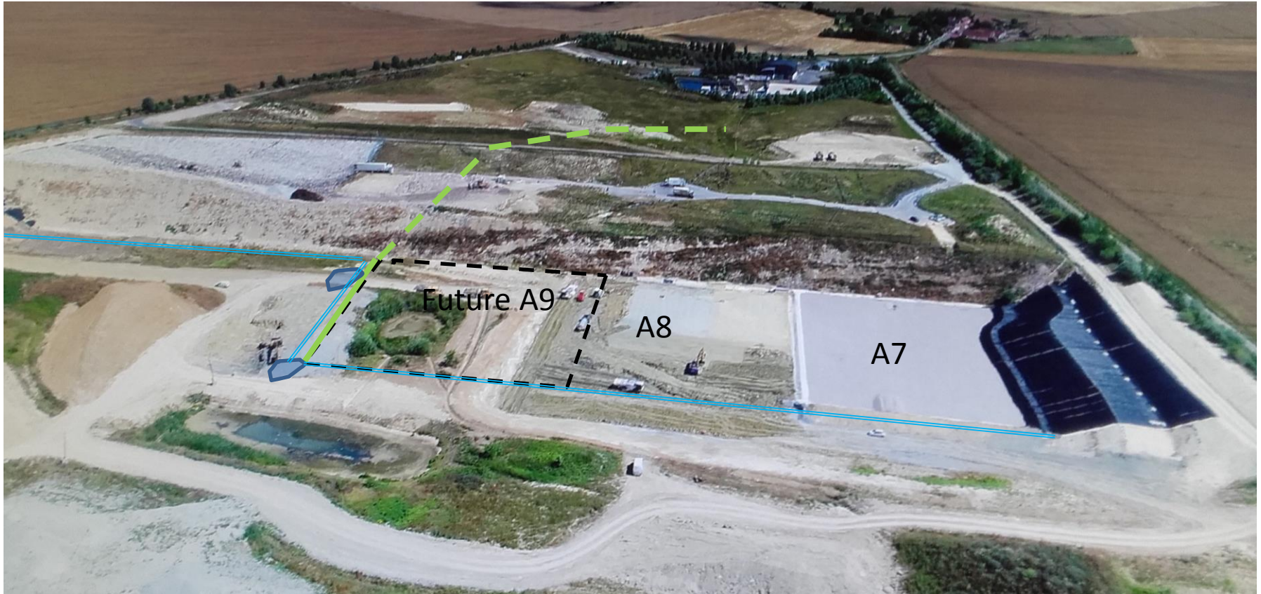
Réalisation de l'alvéole 9 et travaux associés
