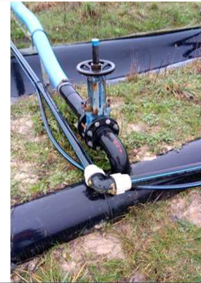
Réseau lixiviat et amenée d'air comprimé installés le long du réseau biogaz existant
