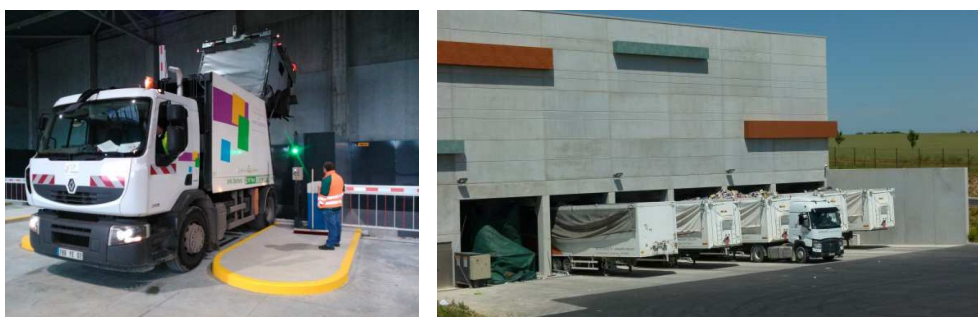
Photos de la zone de transfert de l'installation d'Urvillers
